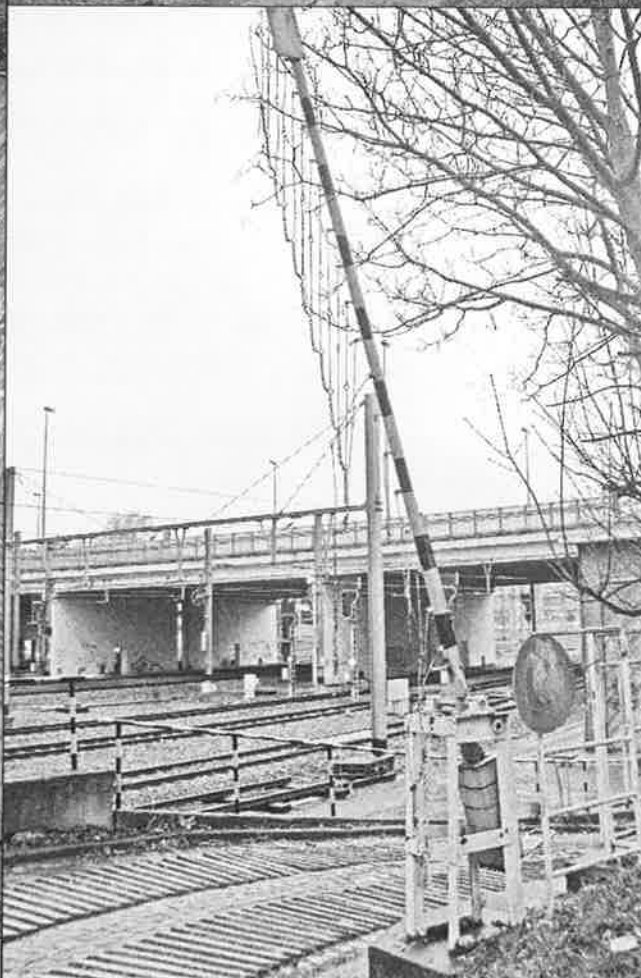
Boulevard d'Herbatte : rampe d'accès pour les véhicules routiers, sur la droite le garage
